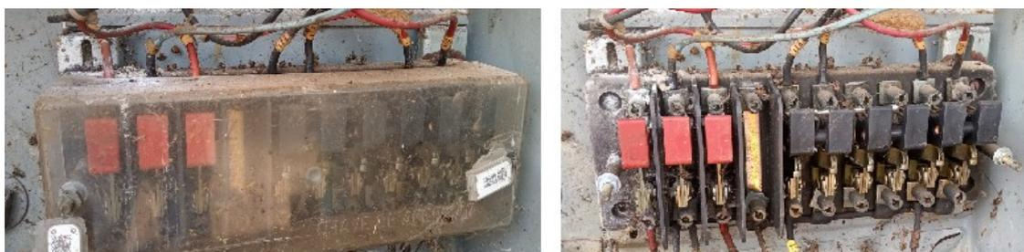
Imagem 04 – Interruptores tipo faca ou chaves liga e desliga.
